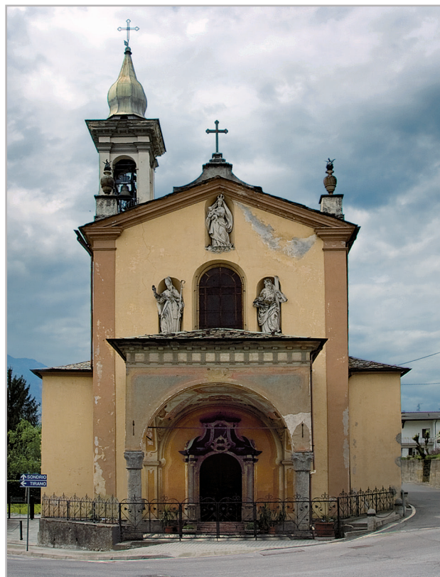
Facciata e portico (foto: M. Brigatti)
